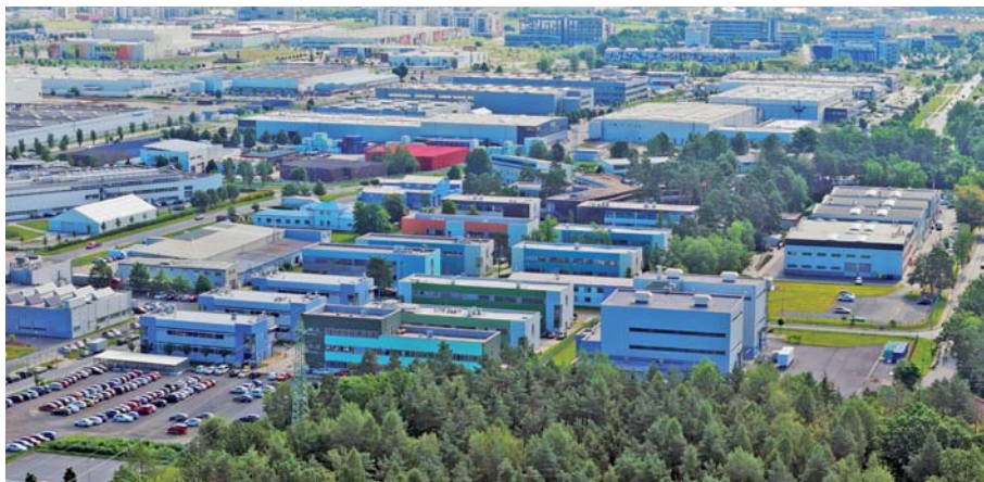
Areál Vědeckotechnického parku a budovy ZČU na Borských polích
